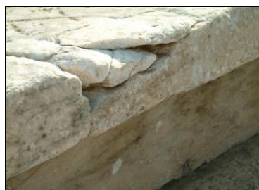
Δημιουργία μεγάλων ή μικρών κενών – αρμών που προέκυψε μετά τις συγκολλήσεις θραυσμάτων κι εξαιτίας της απώλειας υλικού.
