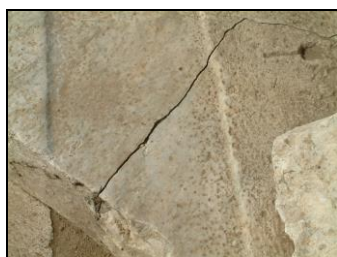
Διαμπερές ρήγμα σε μαρμάρινο μέλος και χάσμα σε πωρόλιθο
