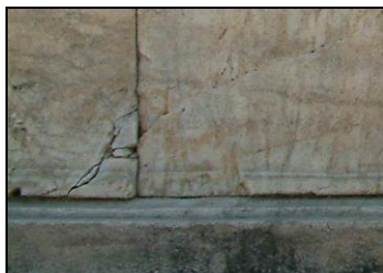
Ετοιμόρροπα θραύσματα που ορίζονται από ρωγμή
