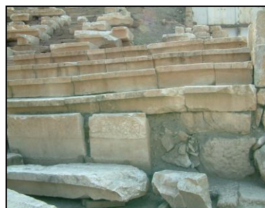
Καθιζήσεις και εξάρσεις στο νοτιοανατολικό τμήμα του κοίλου
