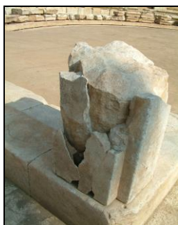
Δημιουργία μεγάλων ή μικρών κενών – αρμών που προέκυψε μετά τις συγκολλήσεις θραυσμάτων κι εξαιτίας της απώλειας υλικού.
