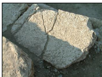
Διαμπερές ρήγμα σε μαρμάρινο μέλος και χάσμα σε πωρόλιθο
