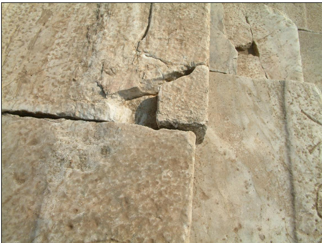
Μεγάλα και μικρότερα κενά (αρμοί συγκόλλησης) που έχουν προκύψει μετά την συγκόλληση θραυσμάτων.
