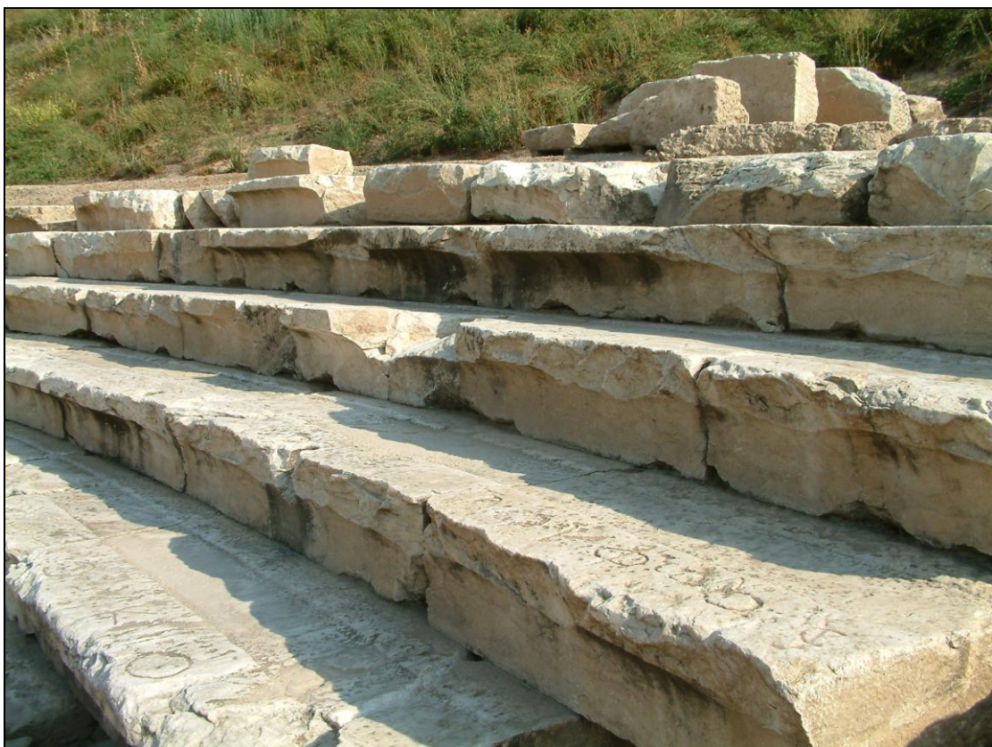
Πλήθος απολαξεύσεων κυρίως στις όψεις των εδωλίων του κοίλου.
