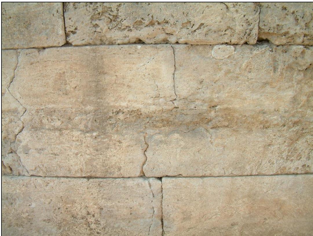
Πλήθος επιφανειακών ρωγμών σε δόμους από πωρόλιθο
