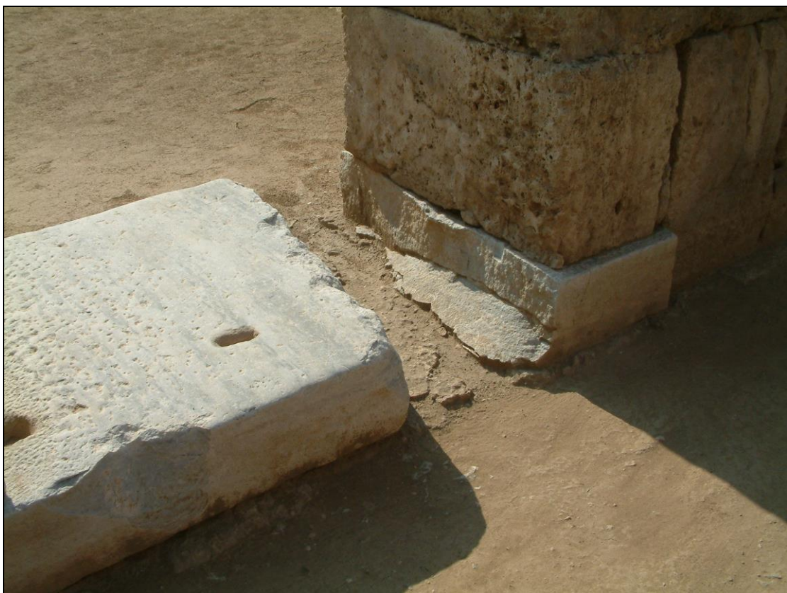
Απώλεια τμήματος σε κατώφλι της σκηνής
