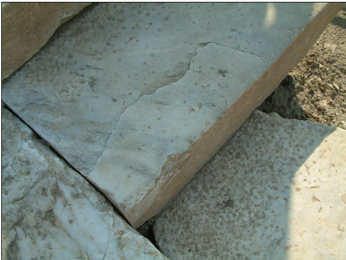
Αποφλοιώση σε μαρμάρινη κλίμακα
