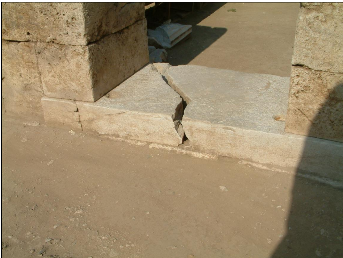
Θραύση λόγω μετακίνησης σε μαρμάρινο κατώφλι της σκηνής.
