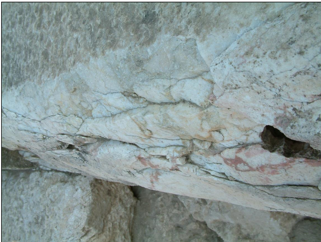
Επάλληλες αποφλοιώσεις σε επιφάνεια θραύσης.
