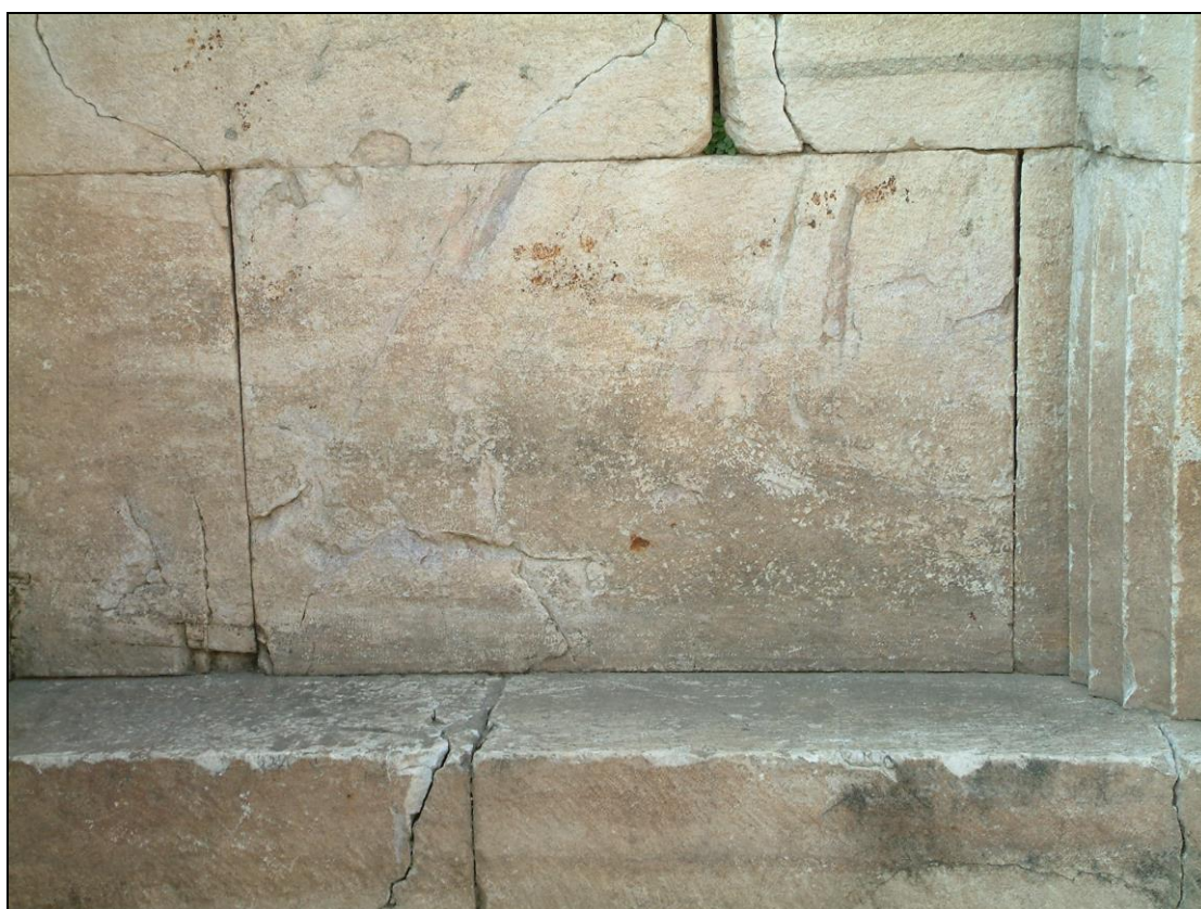
Πλήθος επιφανειακών ρωγμών, ρηγμάτων και αποφλοιώσεων σε μαρμαρίνους δόμους της σκηνής.
