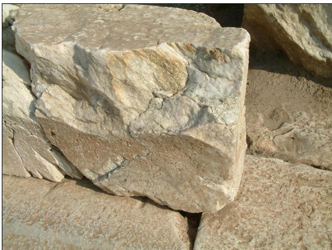
Ρωγμές και αποφλοιώσεις στις επιφάνειες θραύσεως που έχουν προκαλέσει οι μηχανικές τάσεις που ασκήθηκαν κατά τις απολαξεύσεις των εδωλίων στα νεότερα χρόνια.
