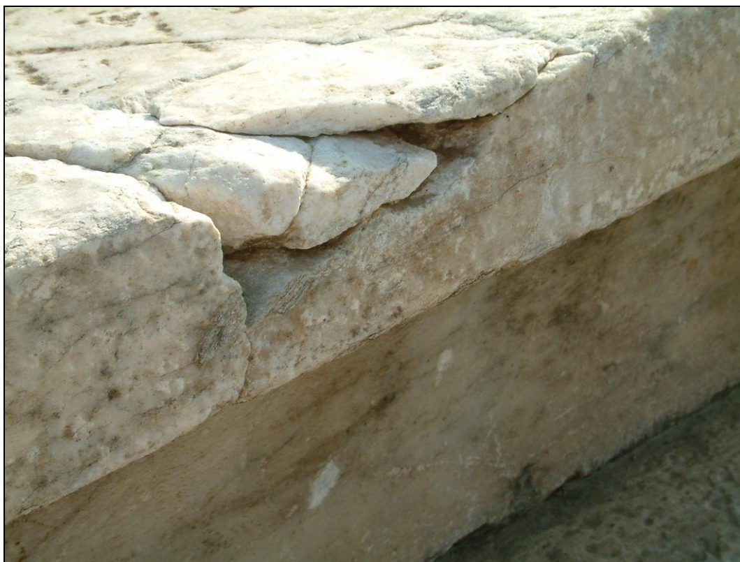
Μεγάλα κενά σε αρχιτεκτονικά μέλη που προέκυψαν μετά την συγκόλληση των επί μέρους θραυσμάτων τους.
